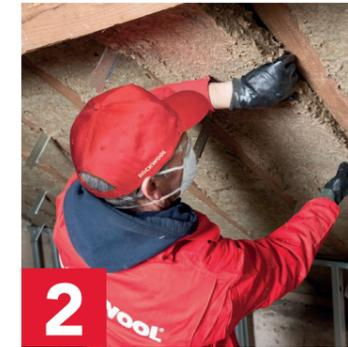
2 Ses bords flexibles facilitent sa mise en œuvre.
