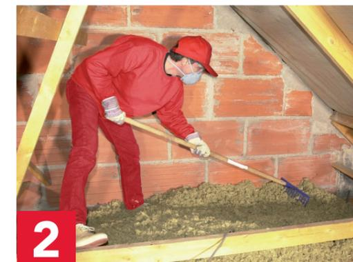
Dans le cas d'un plafond léger, veiller à ne pas créer de surcharge sur le plafond. La trappe d'accès au comble perdu doit être isolée en insérant un panneau d'isolant découpé à la forme de la trappe.
