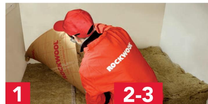
1 - L'isolant doit être placé entre fermettes ou sur le sol plan en orientant le pare vapeur kraft polyéthylène toujours coté chaud de la paroi.
