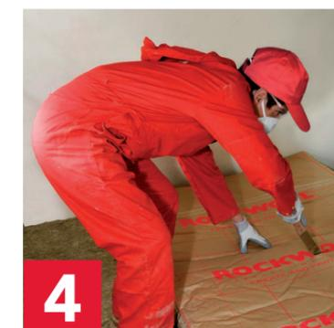
4 - Dans le cas d'une pose en deux ou plusieurs couches les pare-vapeur des couches supérieures doivent être perforés ou lacérés abondamment.
