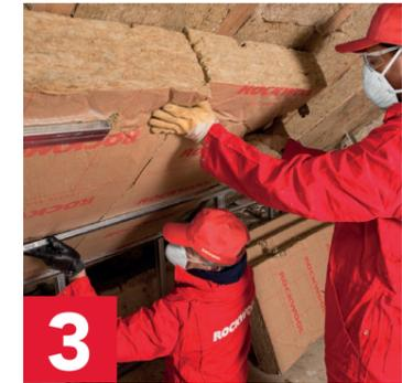
3 Pose de la 2<sup>ème</sup> couche derrière l'ossature métallique.
