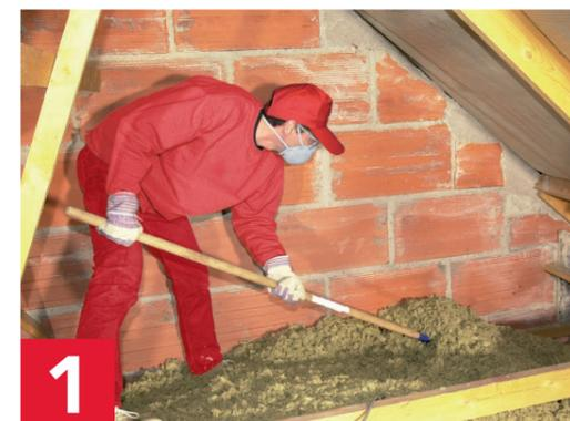
Le Flocon 2 doit être placé entre les fermettes ou sur le sol plan à la pelle puis nivelé au râteau afin d'atteindre l'épaisseur souhaitée.
