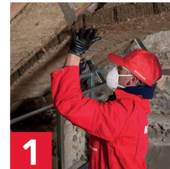
1 Pose de la 1<sup>ère</sup> couche d'isolant Rockcomble entre les chevrons.
