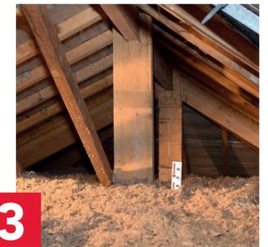
Le poseur vérifie l'épaisseur de laine. Un exemplaire de la fiche chantier est agrafé dans le comble un autre exemplaire est conservé par l'artisan.
