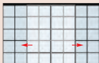
3. Cloison verrière à carreaux carrés
