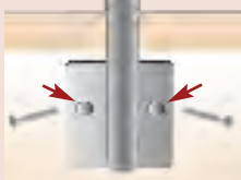
Pose sur platines en applique (à l'anglaise)
