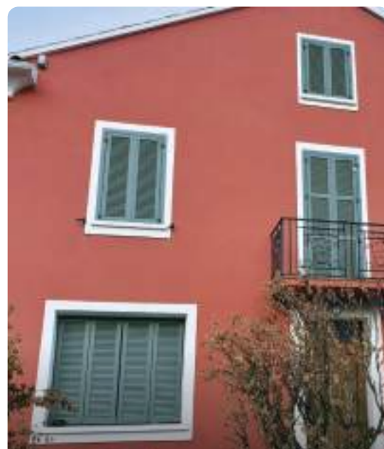
Volets coulissants-pliants à cadre 1/3 lames persiennes ajourées et lames toute hauteur. Finition peinture en option. Coloris : vert réséda RAL 6011.
