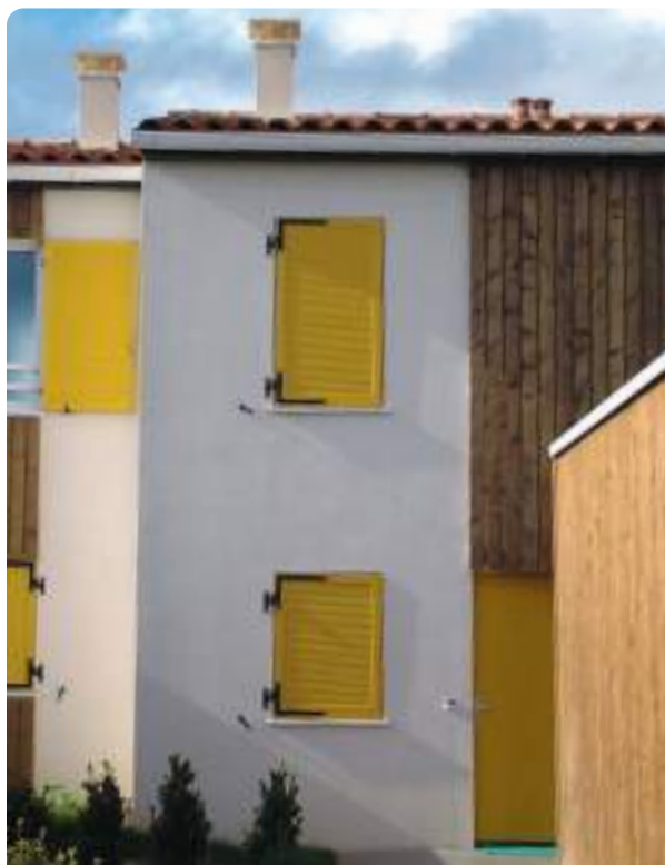
Volets battants à cadre en bois, un vantail lames persiennes jointives, finition peinture. Coloris : jaune zinc RAL 1018 en option. Quincailleries coloris noir en standard.
