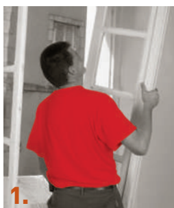
1. Dégondage des ouvrants.
