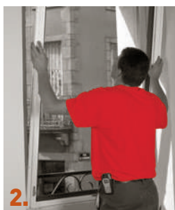
2. Mise en place de la nouvelle menuiserie.
