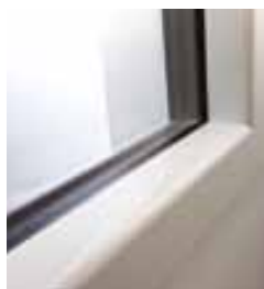
GLAÇAGE DU PROFIL PVC
